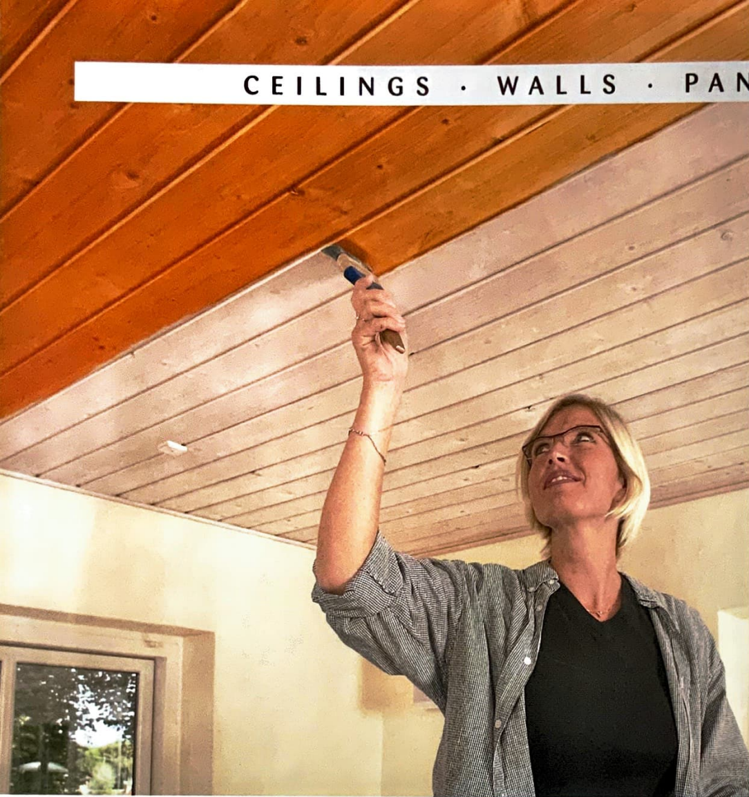
日焼けした天井板にWOCAウッドケア・デンマークのパネルホワイトを塗ります。
